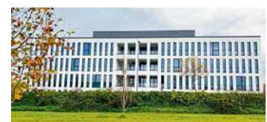
Der Callcenter-Betreiber Amevida bezieht einen Neubau im Herzen des Schalker Vereins. AMEVIDA
